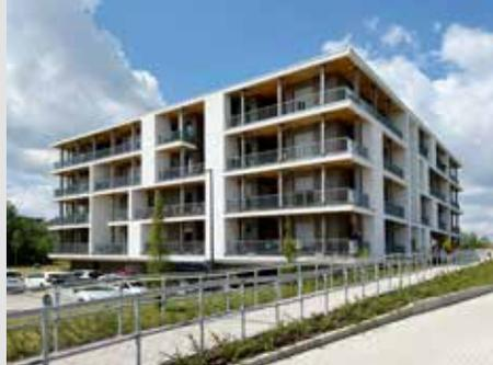
System effizient funktioniert, wird es durch eine energieoptimierte Bauweise perfekt unterstützt. Das 4-geschossige Gebäude mit einem eindrucksvollen Atrium-Treppenhaus als Mittelpunkt ist in Holzmassiv- und Stahlbetonbauweise errichtet.
