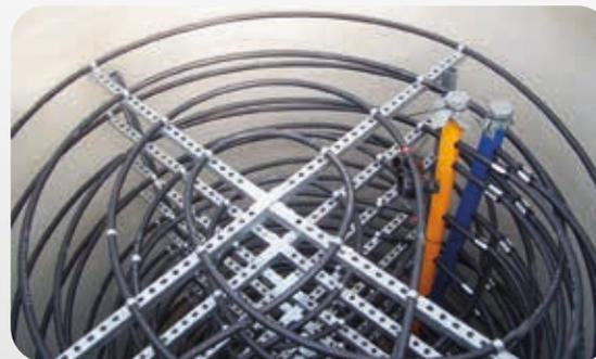
*Der Eisspeicher des Solarhauses besteht aus einer Zisterne mit einem Durchmesser von 8 Metern und einer Höhe von 4 Metern, die unter der Erdoberfläche vergraben wird. Die Zisterne selbst ist aus Beton und nicht isoliert. Im Inneren der Zisterne befinden sich große Spiralen aus Leitungen, in denen eine frostsichere Flüssigkeit (Sole) zirkuliert.*
